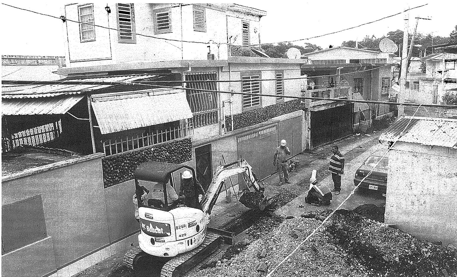
BRIGADAS de obreros externos junto con residentes de la Península de Cantera trabajan en la construcción de un sistema sanitario para toda la comun
